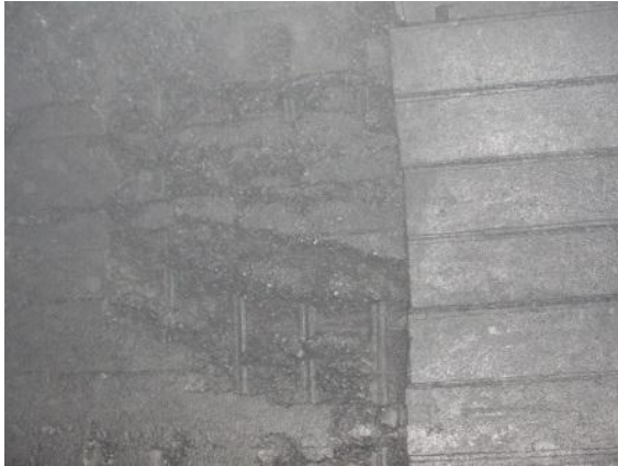
ფოტო 6-8: გვირაბში არსებული ეროზირებული უბნები სადაც გაშიშვლებულია არმატურა; პკ 29+50 (მარცხნივ); პკ 32+20 (მარჯვნივ)
