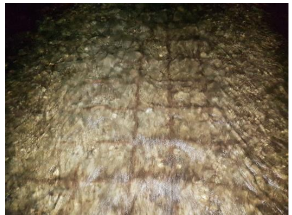
ფოტო 6-3: არმატურის დამცავი ფენა გარეცხილია და შეიმჩნევა არმატურის ნაშვრები დაზიანების ტიპი I; 3კ 66+60 (მარცხნივ); დაზიანების ტიპი I; 3კ 75+30 (მარჯვნივ)
