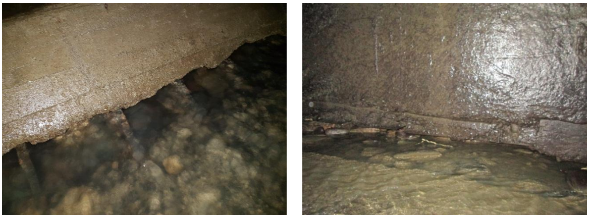
ფოტო 6-5: ძირის და კედლის შეერთების ადგილას არსებული დაზიანებები; დაზიანების ტიპი III; პკ 32+50 (მარცხნივ); დაზიანების ტიპი III; პკ 33+80 (მარჯვნივ)
