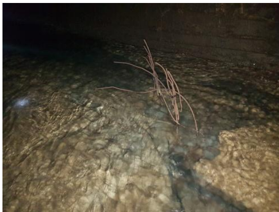
ფოტო 6-3: არმატურის დამცავი ფენა გარეცხილია და შეიმჩნევა არმატურის ნაშვრები დაზიანების ტიპი I; 3კ 66+60 (მარცხნივ); დაზიანების ტიპი I; 3კ 75+30 (მარჯვნივ)
