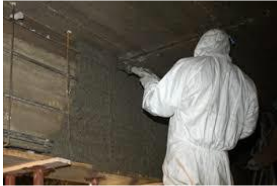
ფოტო 7-4: MAPEGROUT T60-ის გამოყენება
