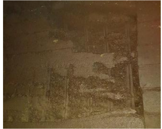
ფოტო 6-8: გვირაბში არსებული ეროზირებული უბნები სადაც გაშიშვლებულია არმატურა; პკ 29+50 (მარცხნივ); პკ 32+20 (მარჯვნივ)
